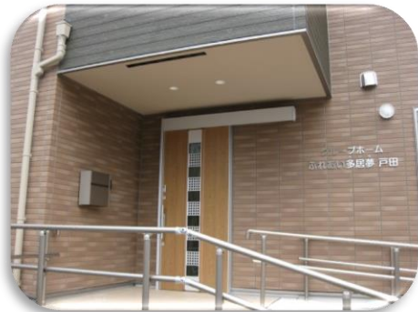
玄関 スロープのある広々とした玄関はお出かけにも安心です。
